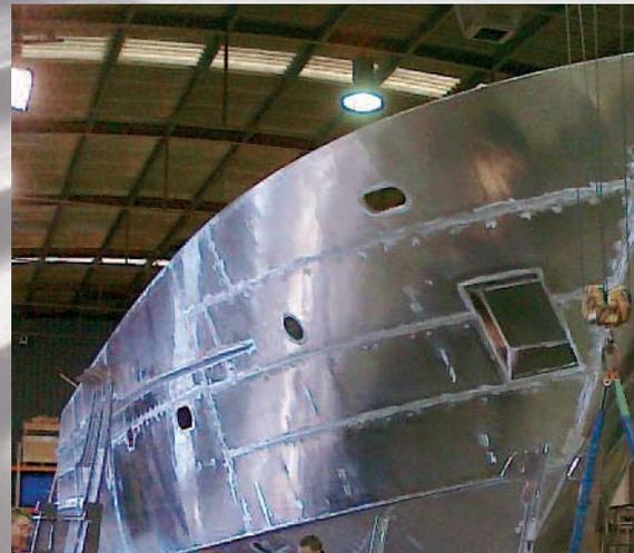
Travaux sur la coque d'un navire
